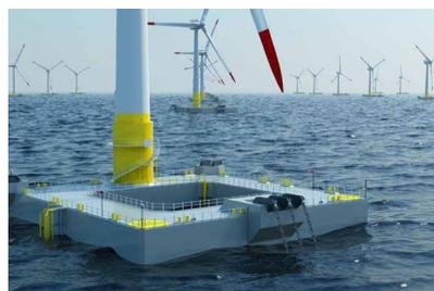
Le projet comprend la fourniture, la construction et l'installation d'un démonstrateur de flotteur, ancrage et câble dynamique de 2 MW sur le site d'essai du SEM-REV au large du Croisic. La construction de la coque est réalisée par BOUYGUES TRAVAUX PUBLICS et l'installation sur le site en mer est prévue en 2017. Les essais de qualification de ces composants seront réalisés par l'IFSTTAR.
