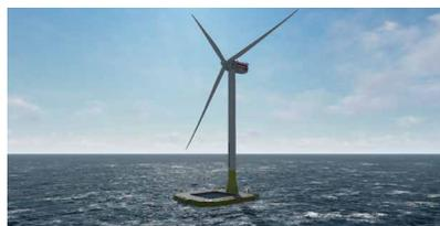
composé de flotteurs en béton et d'éoliennes, de lignes caténares, d'ancrages et de câbles inter-éoliennes et d'une liaison de raccordement au Réseau Public de Transport d'électricité.
